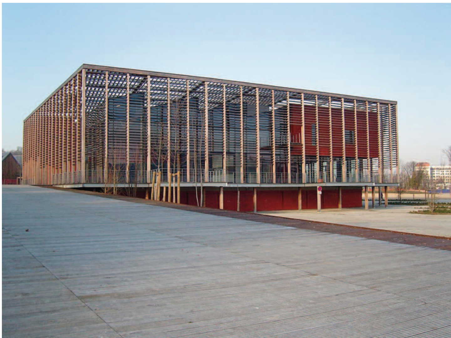
Vue générale de la rampe d'accès / Overview of the access ramp
