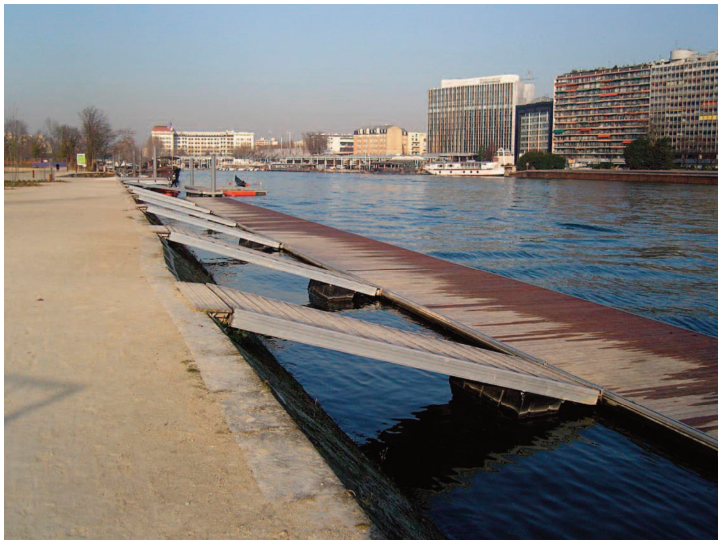
Les pontons d'aviron et kayak / The multi-purpose hall
